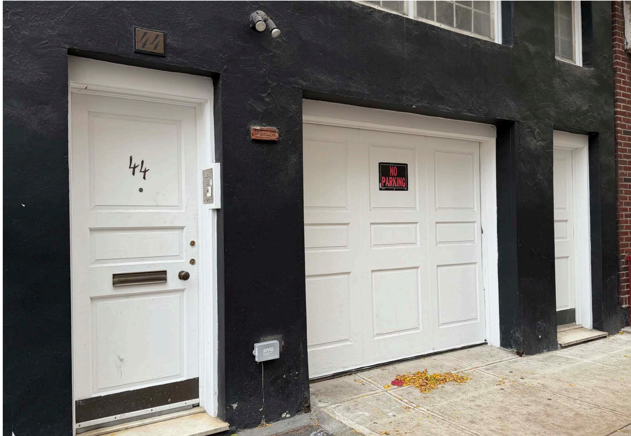
EXISTING GARAGE DOOR
