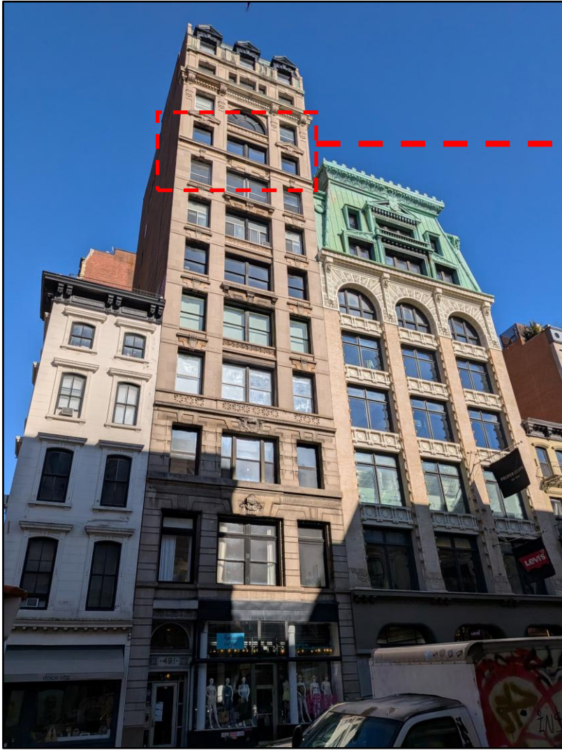
491 Broadway, east façade, April 2026. (J. Peu-Duvallon)
