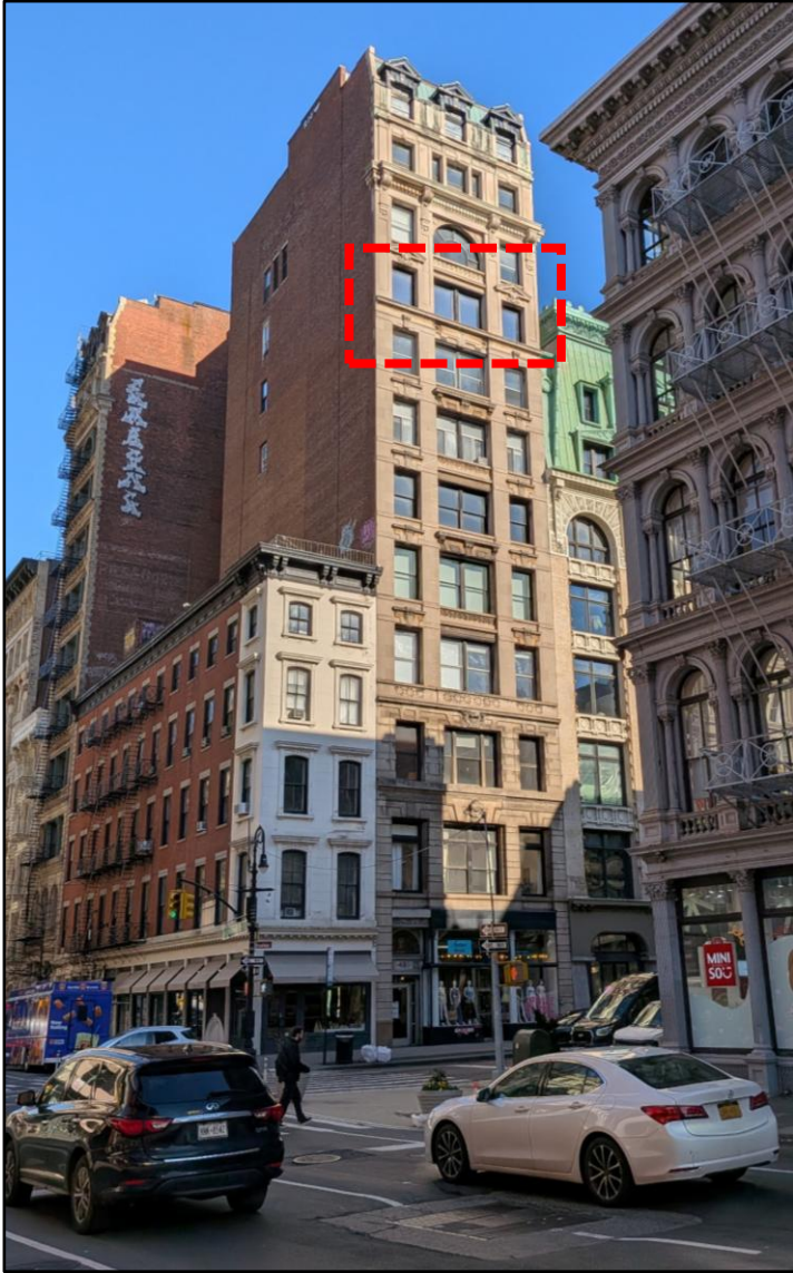
491 Broadway east façade, April 2026. (J. Peu-Duvallon)
