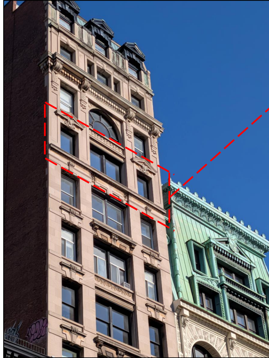
491 Broadway partial east façade, April 2026. (J. Peu-Duvallon)
