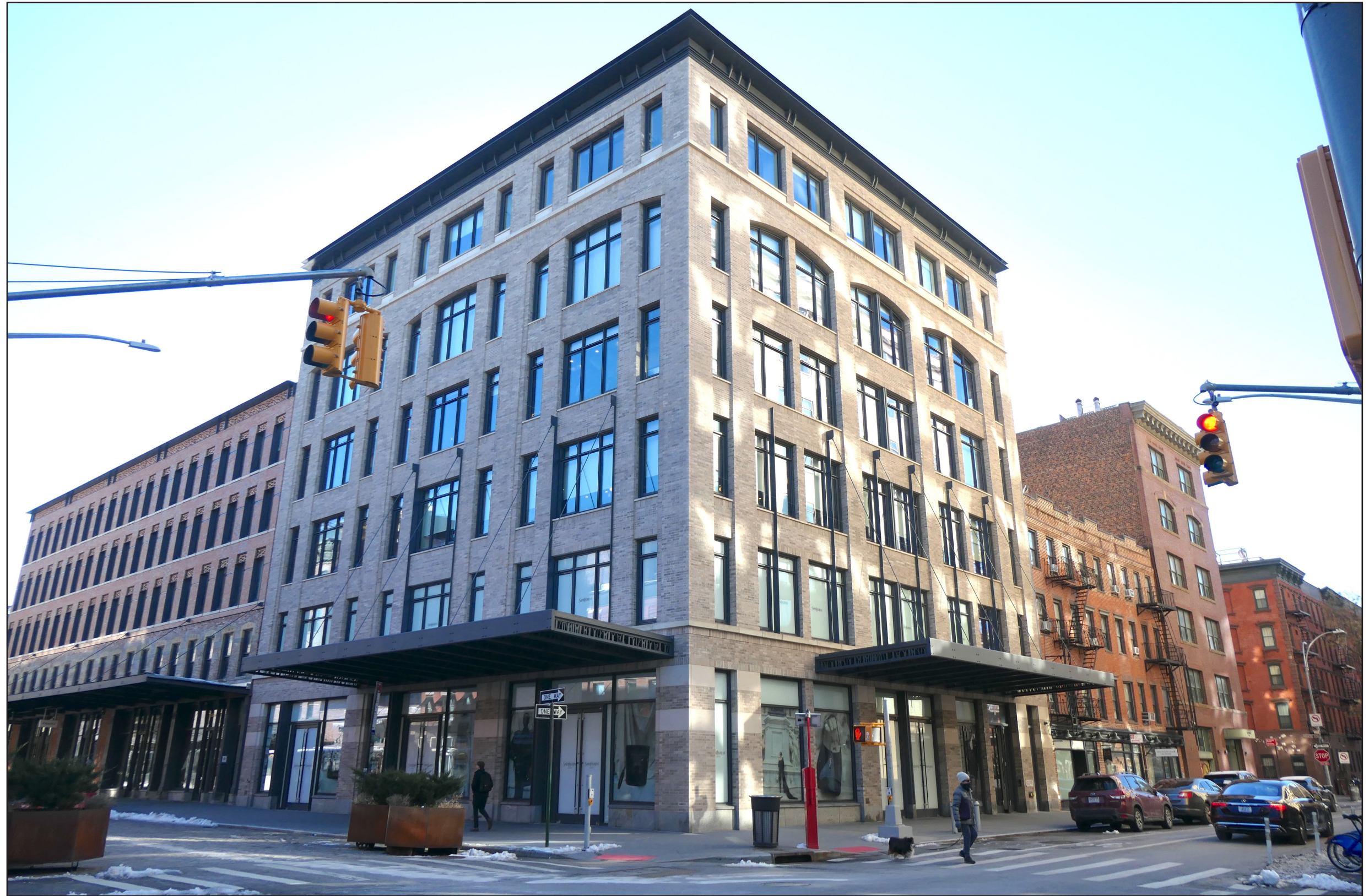
70-74 GANSEVOORT STREET - EXISTING CONDITION
