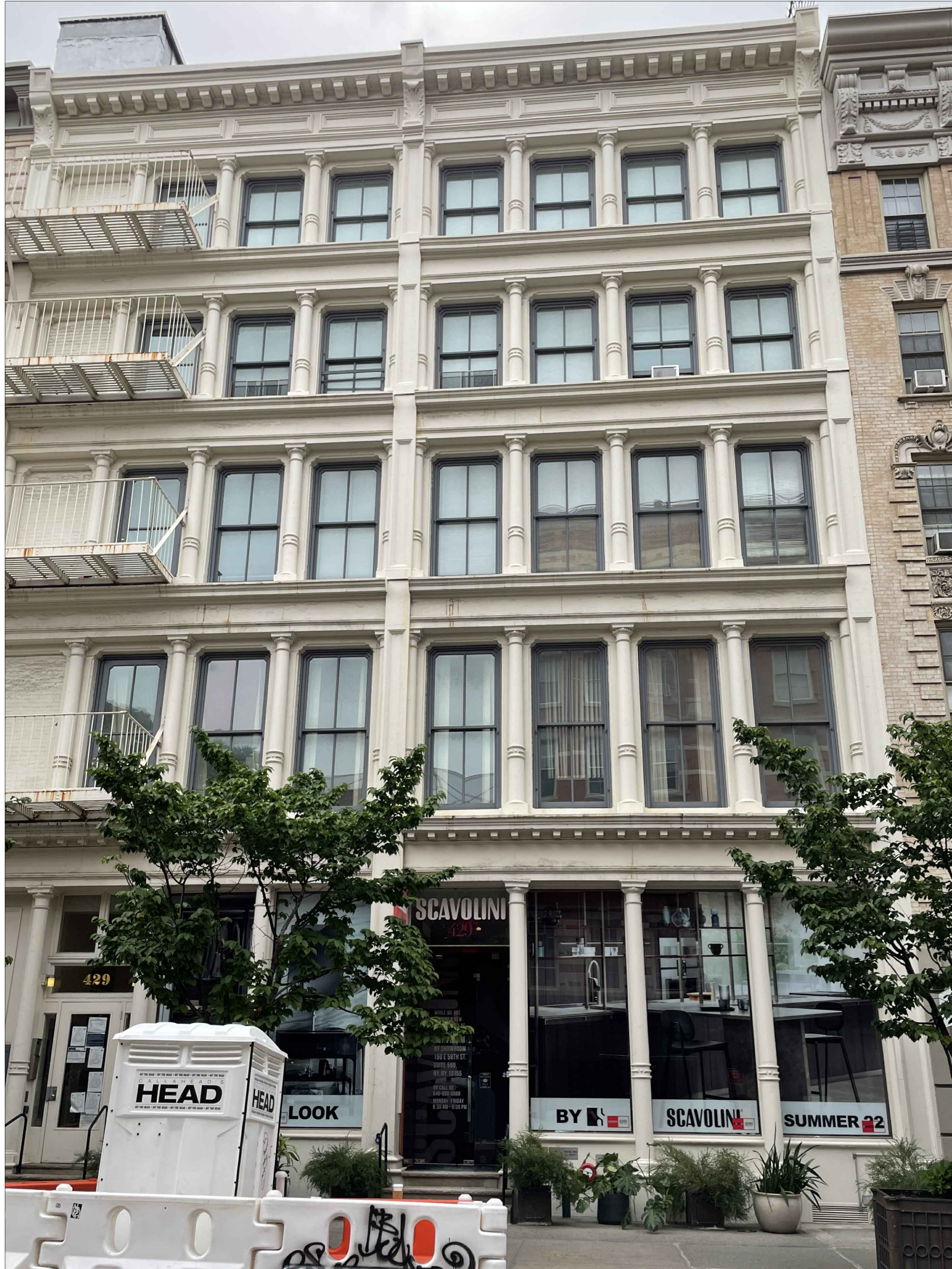
① 2022.06.20 STREET FACADES
