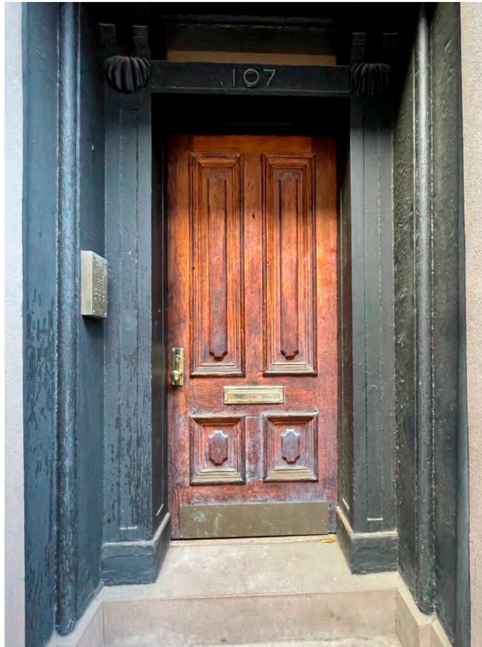
Existing 107 front door
