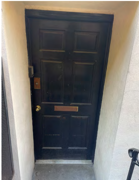
Existing 105 areaway door
