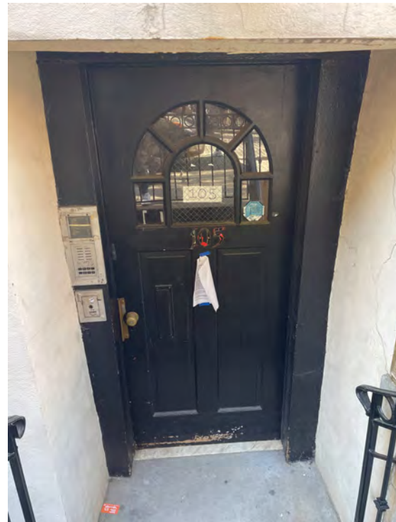
Existing 105 areaway door
