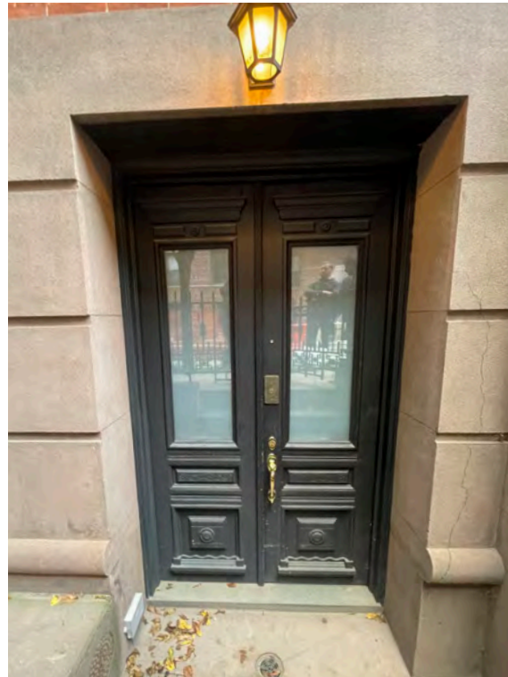
Existing 107 areaway door
