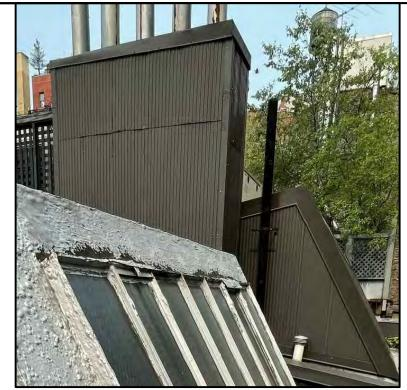
DARK ALUMINUM FASCIA & CORRUGATED CLADDING ON EXISTING CHIMNEY & SKYLIGHTS AT #23
