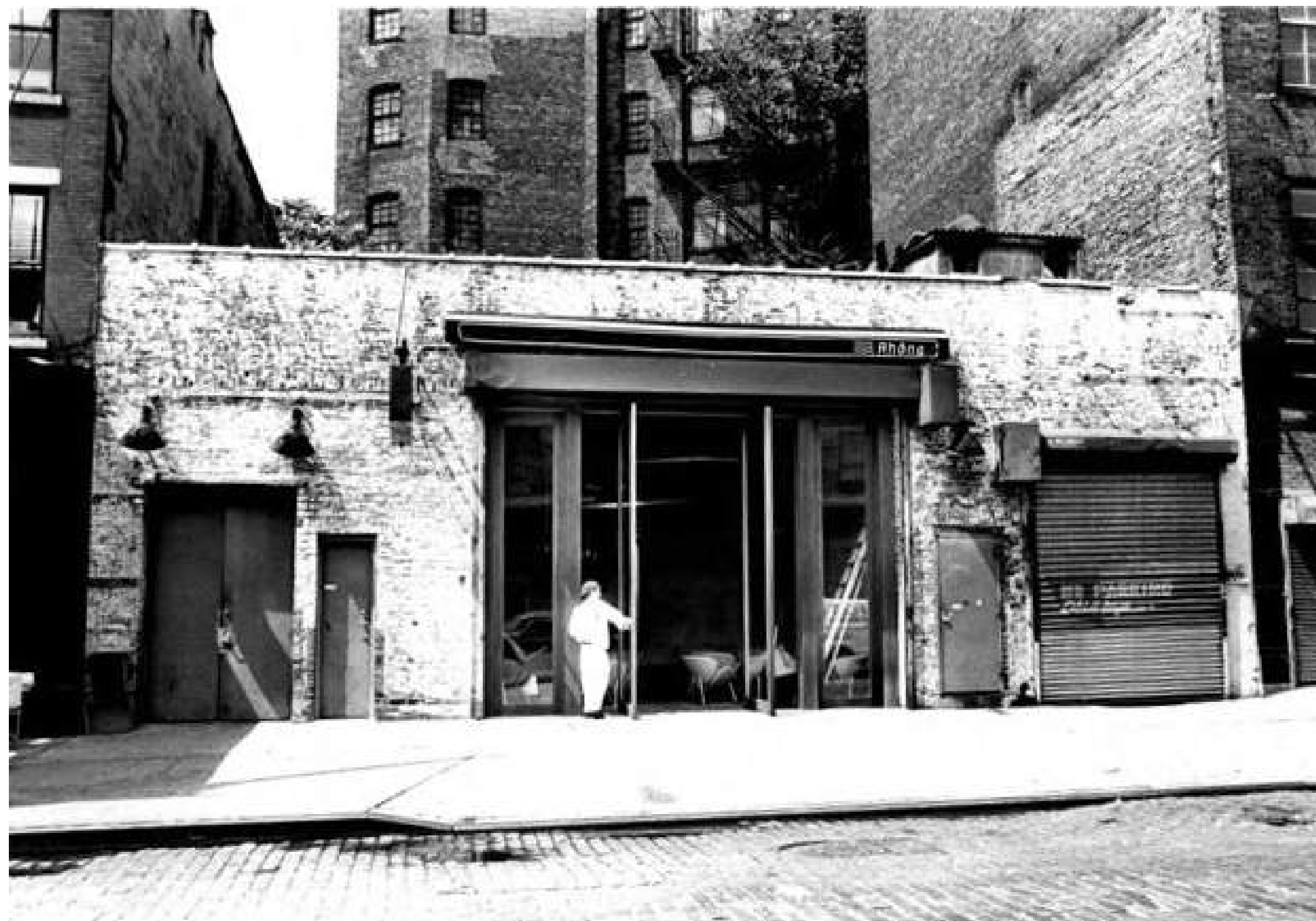
63 GANSEVOORT STREET - 2003 (LPC DESIGNATION REPORT)
