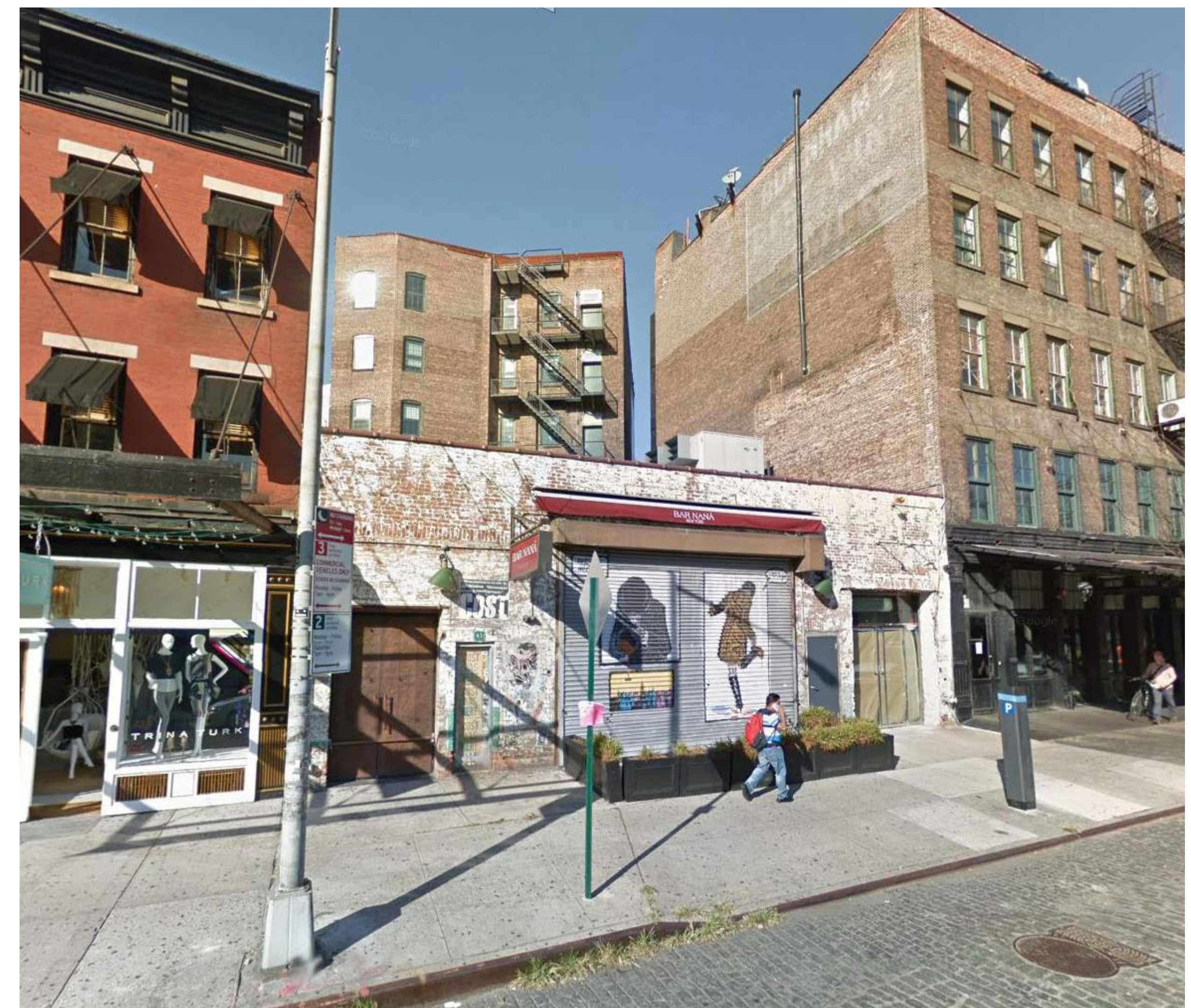
63 GANSEVOORT STREET - EXISTING
