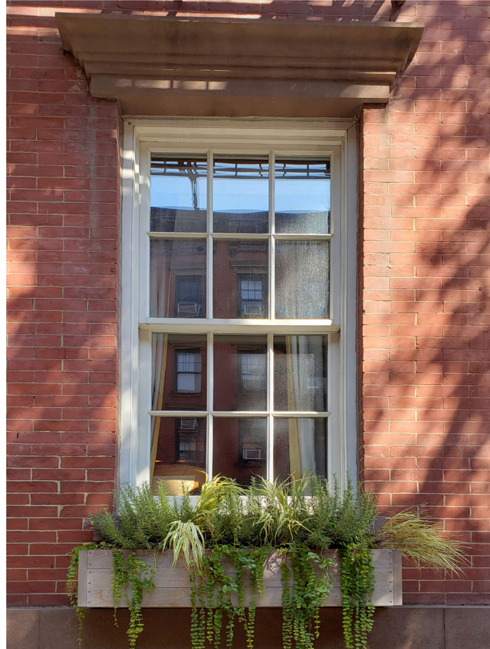
02 | ENLARGED EXISTING WINDOW PHOTO (TYP.) SCALE: N.T.S.
